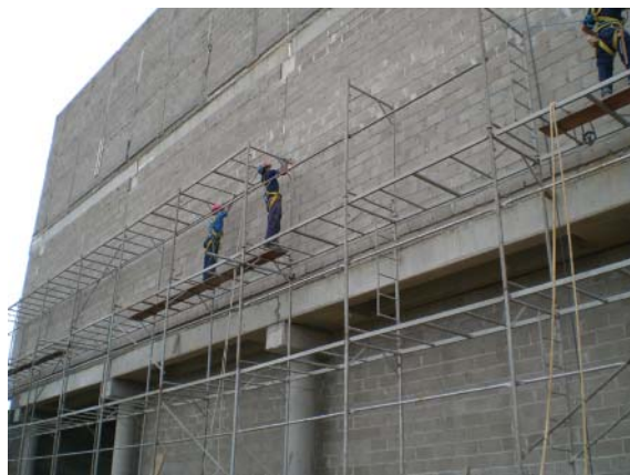
Figura 4 – Andaime fachadeiro em montagem
