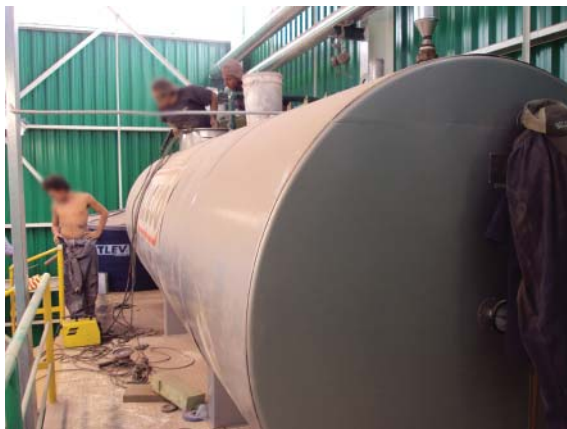
Figura 62 – Atividades em espaço confinado
