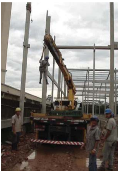
Figura 36 – Equipamento de guindar utilizado no transporte vertical de trabalhadores
