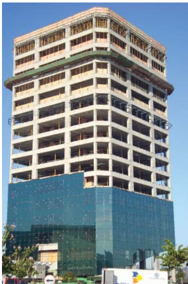
Figura 30 – Instalação de painéis unitizados de vidro em fachada
