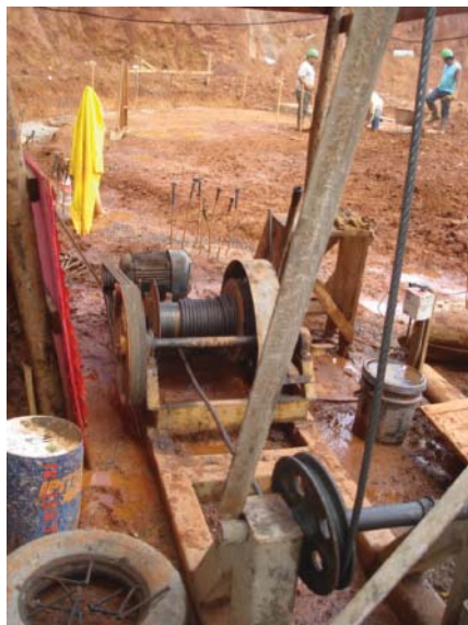
Figura 46 – Utilização de componentes para movimentação precários e sem enclausuramento
