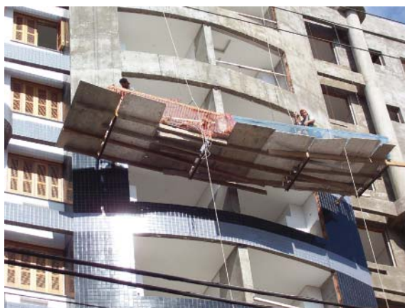
Figura 9 – O caráter provisório da estrutura não pode ser sinônimo de precário
