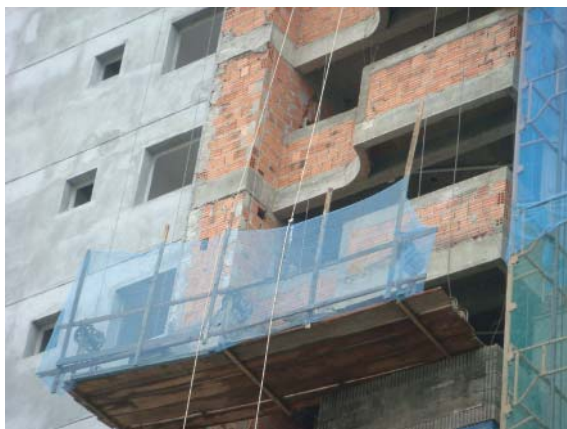
Figura 6 – Andaime suspenso mecânico montado em obra
