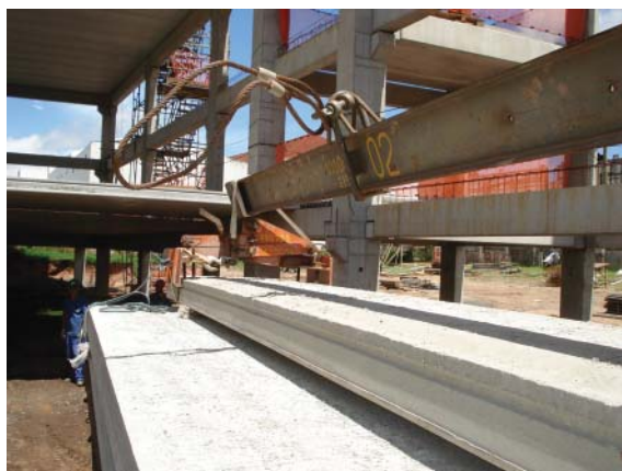
Figura 34 – Equipamento (garra), associado à cinta de carga, utilizado na montagem, movimentação e descarga de lajes pré-moldadas
