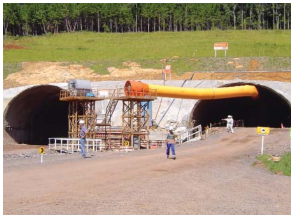
Figura 103 – Túneis em construção
