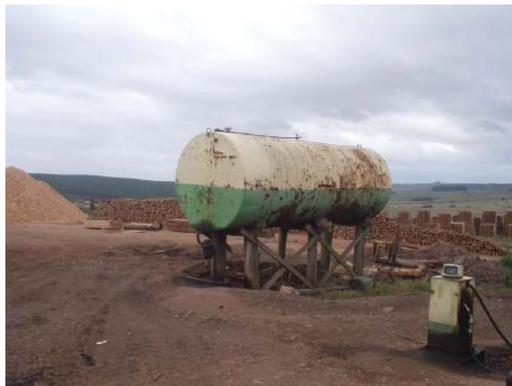
Figura 89 – Tanque de Combustível
