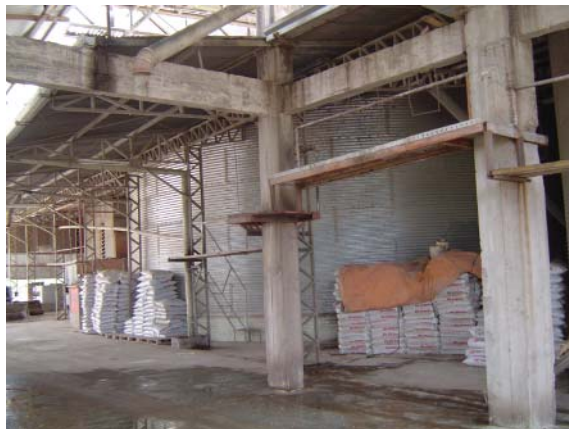
Figura106 – Plataformas de trabalho
