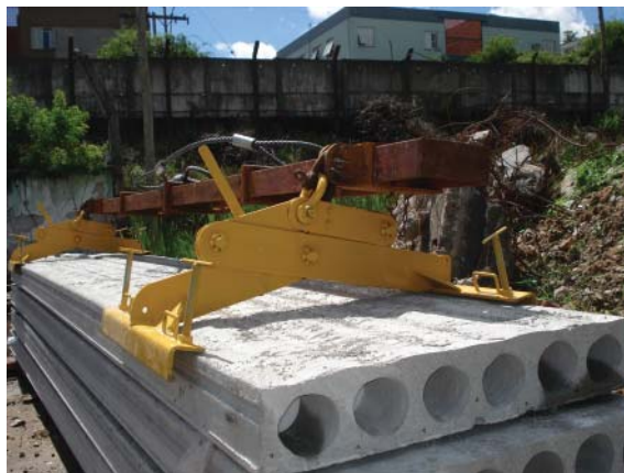
Figura 32 – Equipamento (garra) utilizado na montagem, movimentação e descarga de lajes pré-moldadas
