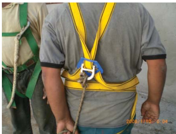
Figura 85 – Improvisação de cinto de segurança e falta de CA
