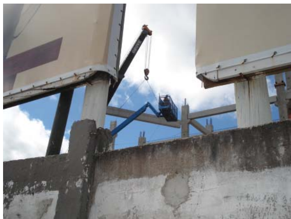
Figura 39 – Utilização simultânea de guindastes na movimentação e descarga de vigas pré-moldadas e de Plataformas de Trabalho Aéreo – PTA
