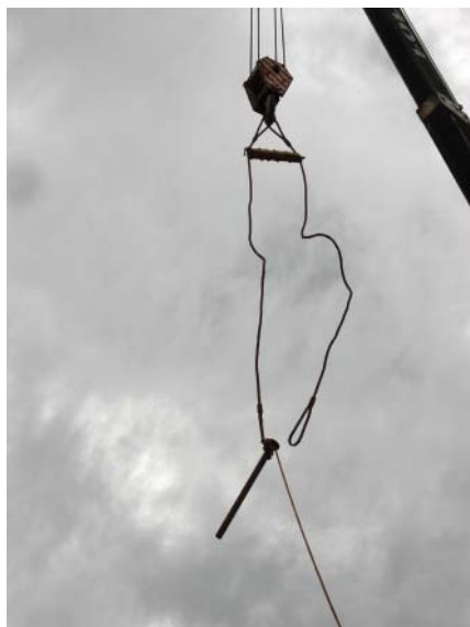
Figura 38 – Sistema de pino utilizado na montagem, movimentação, e descarga de pilares pré-moldados
