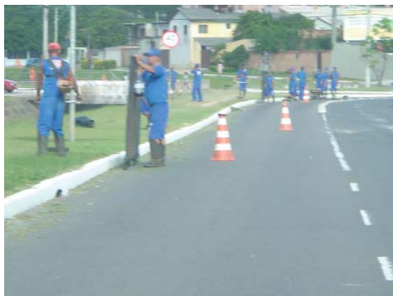
Figura 131 – Roçagem com ausência de sinalização viária adequada, proteção individual e vestimenta com alta visibilidade
