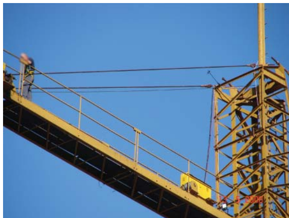
Figura 51 – Vista superior de grua e do acesso à extremidade da lança
