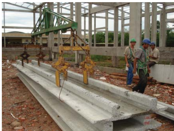
Figura 33 – Equipamento (garra) utilizado na montagem, movimentação e descarga de lajes pré-moldadas
