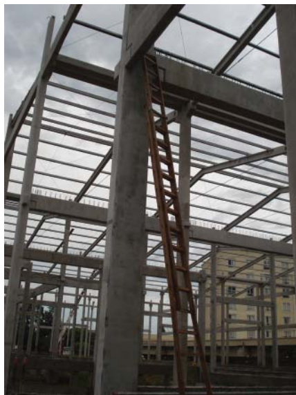
Figura 37 – Escada de mão utilizada pelos trabalhadores na montagem de vigas pré-moldadas
