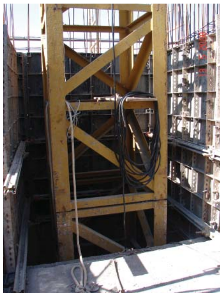
Figura 53 – Detalhe do engastamento da torre
