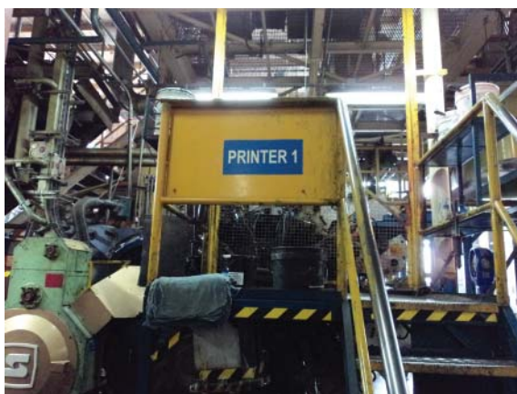
Figura 126 – Vista da plataforma de acesso à área de intervenção
